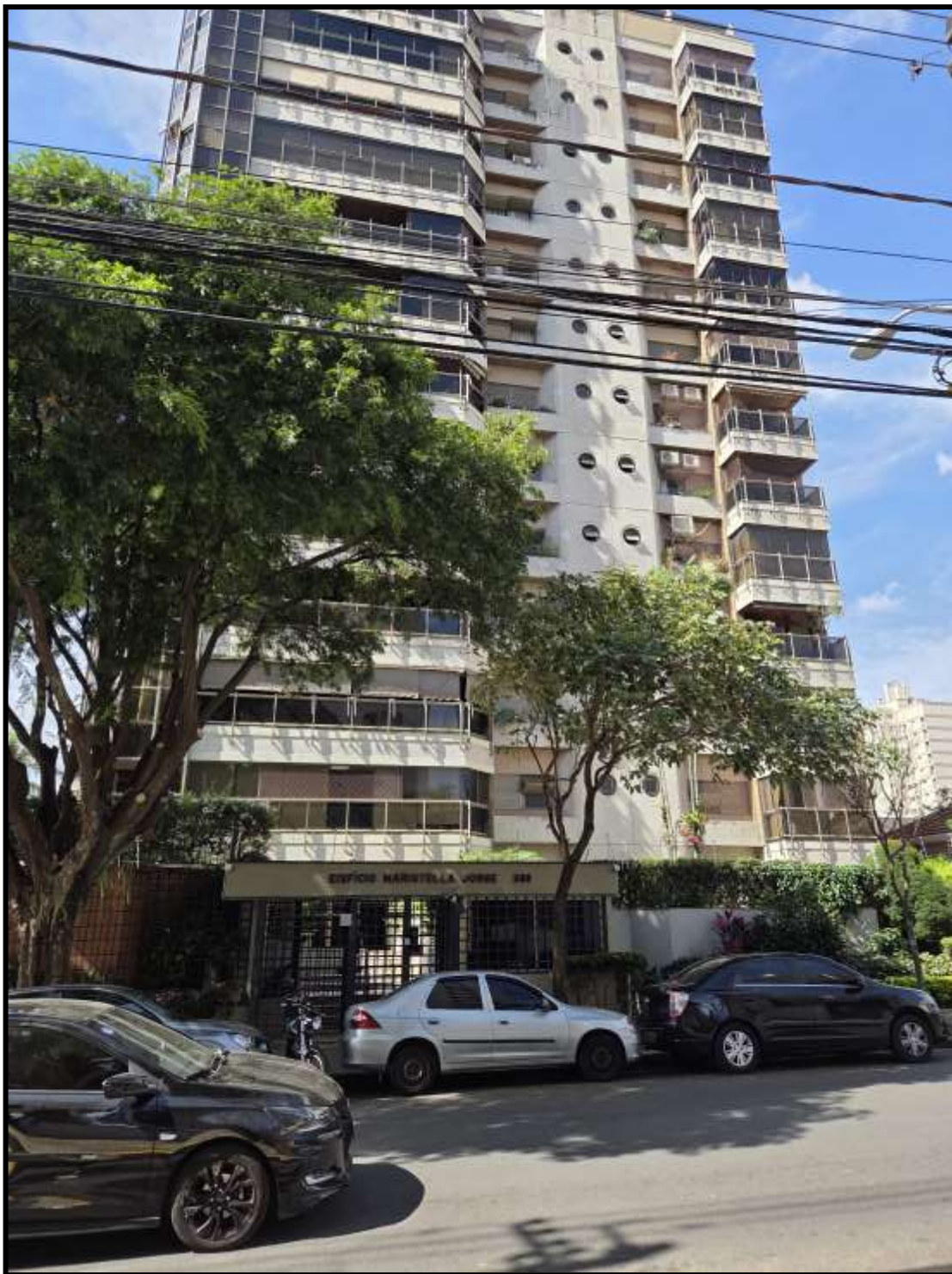
2. Vista da fachada do Edifício Maristela Jorge feito da Rua Olavo Bilac.
