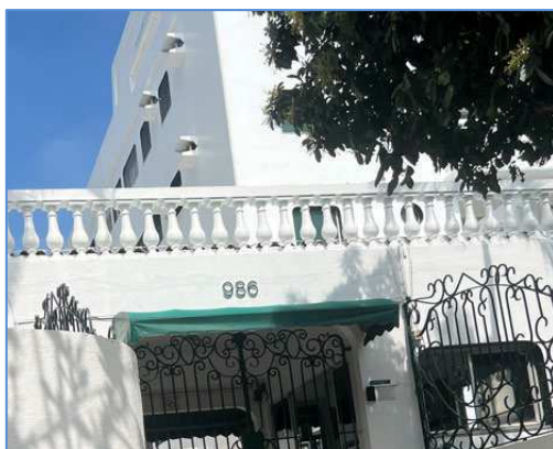
Foto 5 – Vista da fachada do edifício
