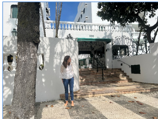
Foto 4 – Vista da fachada do edifício
