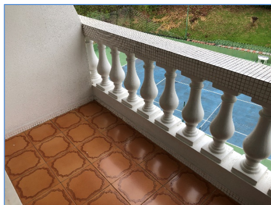
Foto 10 – Vista do terraço do apto. 34
