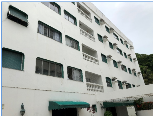
Foto 3 – Vista da fachada do edifício Praias de Monte Carlo
