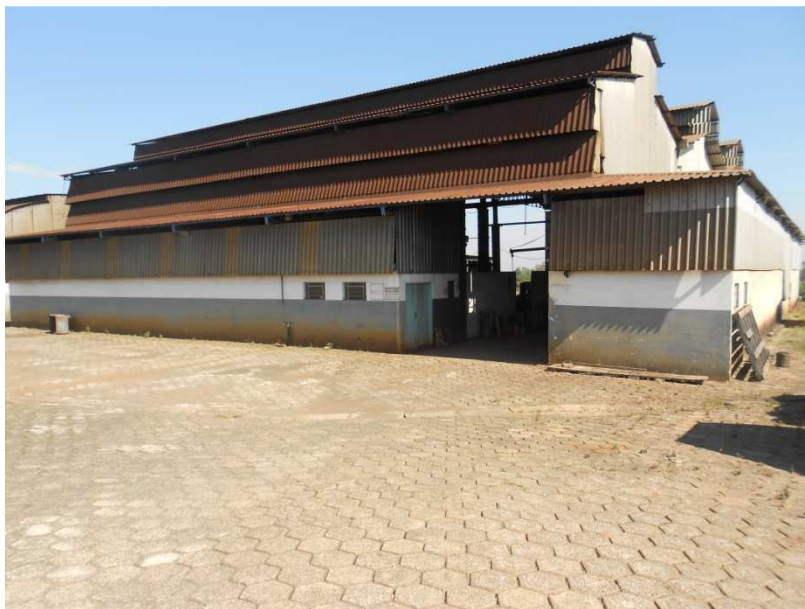
Área externa Galpão 02
