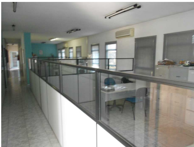
Sala com divisórias ( madeira e vidros)
