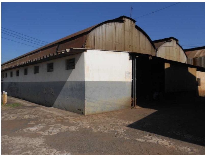
Área externa Galpão -01
