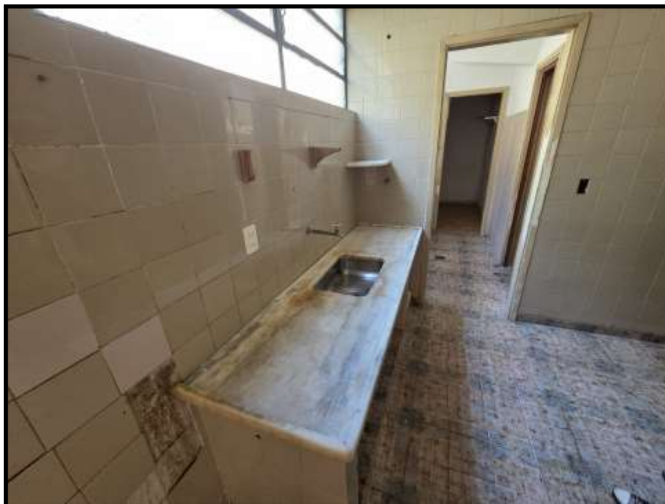
7. Vista interna da cozinha.
