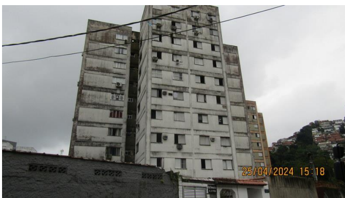
Foto 5 - Vista da fachada frontal do Edifício Guaratuba – Bloco 21.
