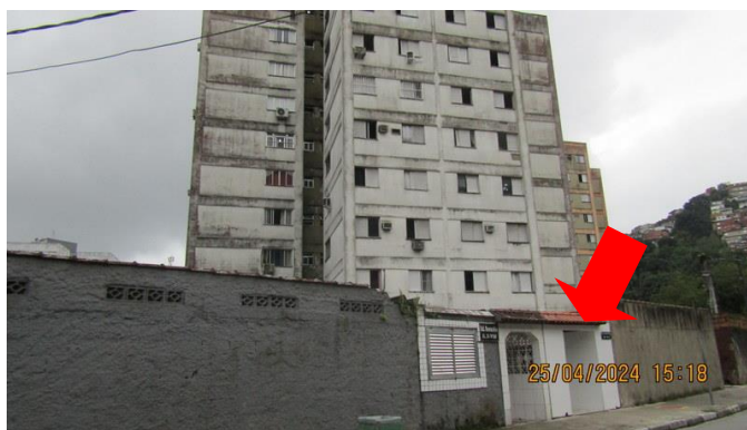
Foto 3 - Vista do portão de acesso ao Edifício Guaratuba – Bloco 21.
