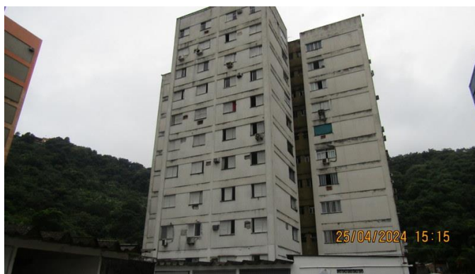
Foto 6 - Vista da fachada de fundos do Edifício Guaratuba – Bloco 21.
