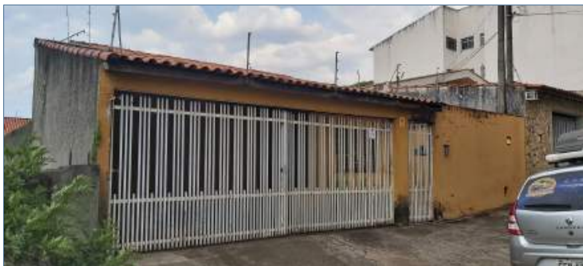
Vista parcial externa frontal do imóvel objeto de Avaliação.
