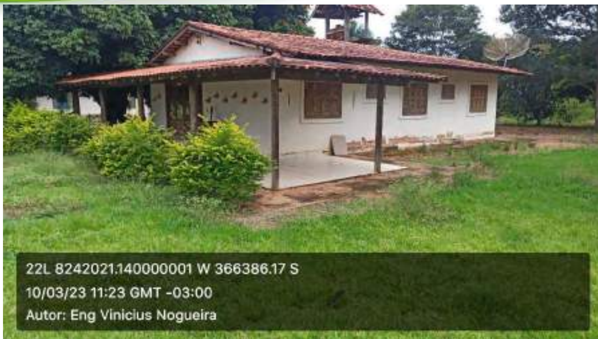
Figura 25 - Casa para funcionários
