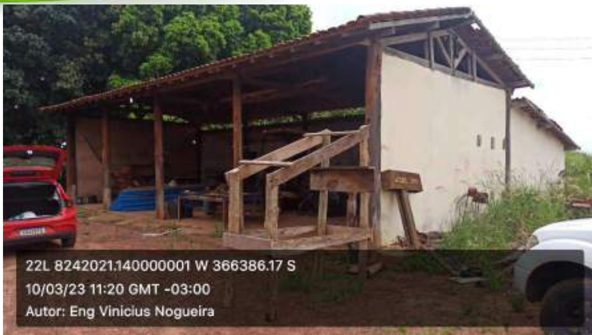
Figura 27 - Galpão para manutenção de máquinas
