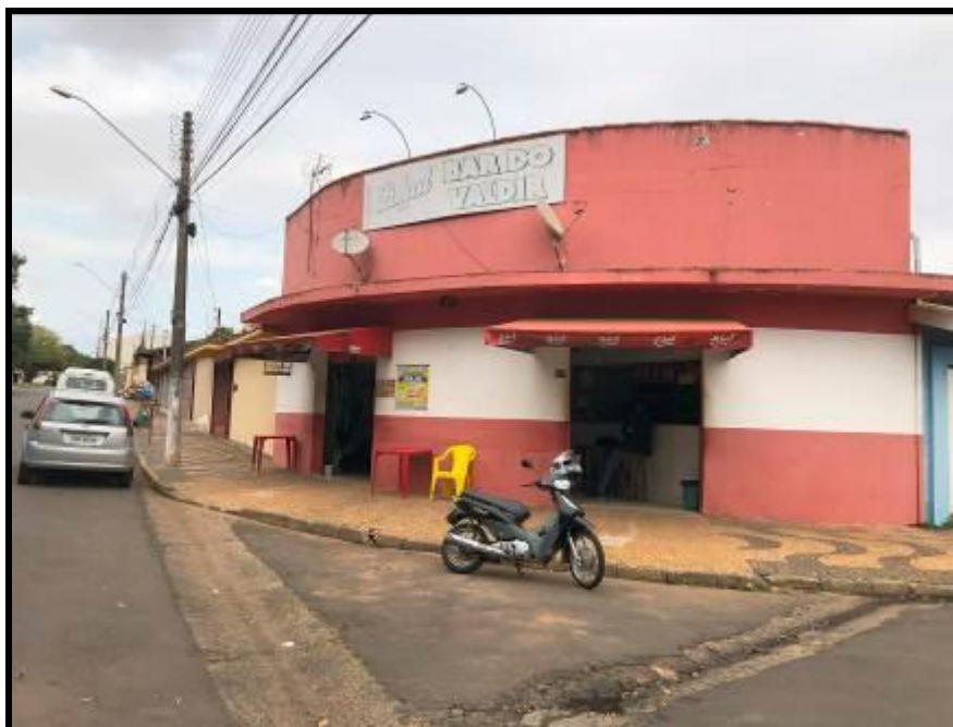
Acesso ao galpão comercial.
