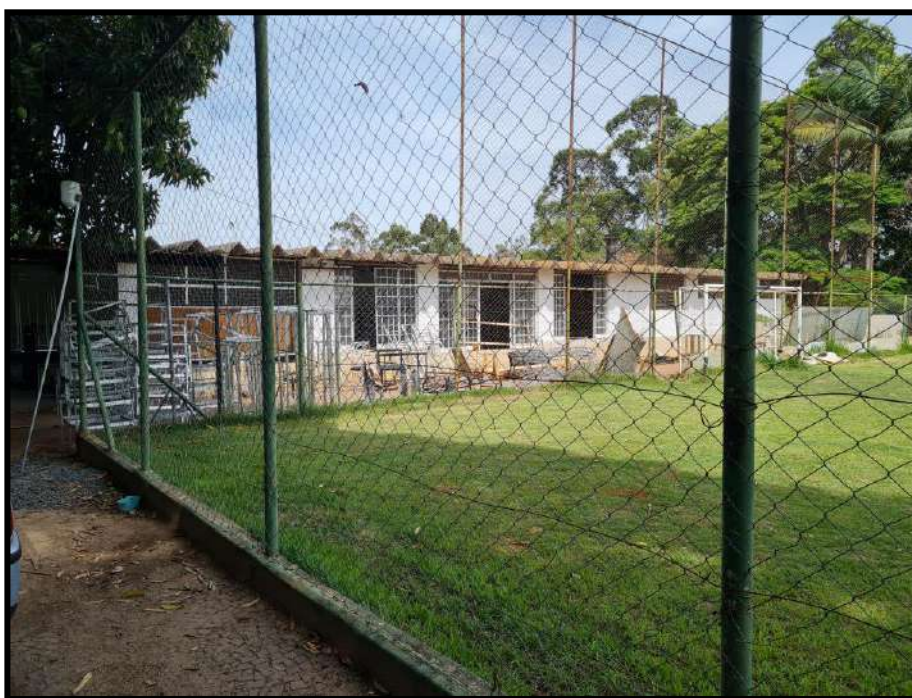
6. VISTA DO GALPÃO SITUADO NOS FUNDOS DO TERRENO.
