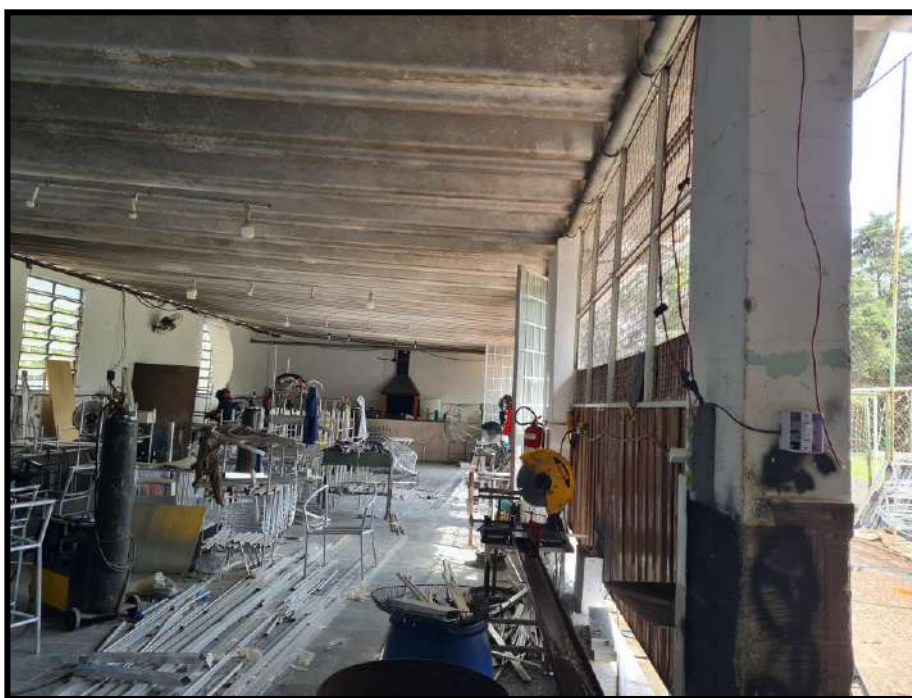
8. VISTA INTERNA DO GALPÃO.
