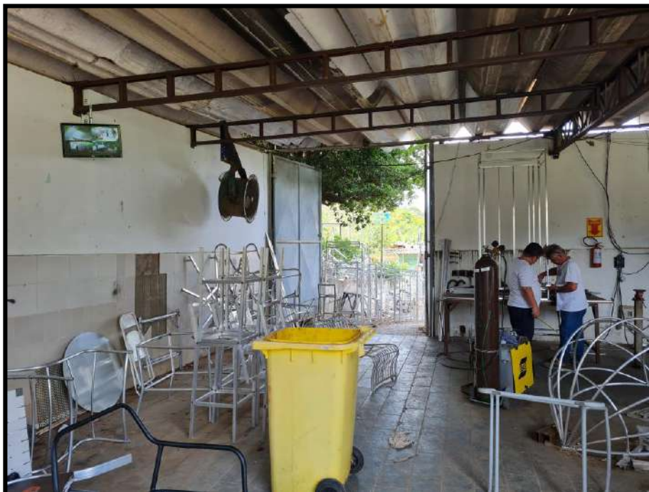
9. VISTA INTERNA DO GALPÃO.
