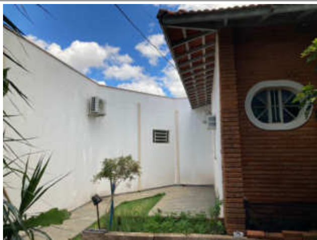
Edificação objeto ligada ao lote confrontante nº. 05 e 04 e área ajardinada.
