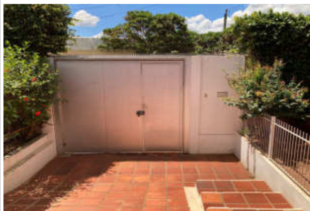
Vista interna - portão social e garagem, acesso pelo lote confrontante nº 05 e 04.
