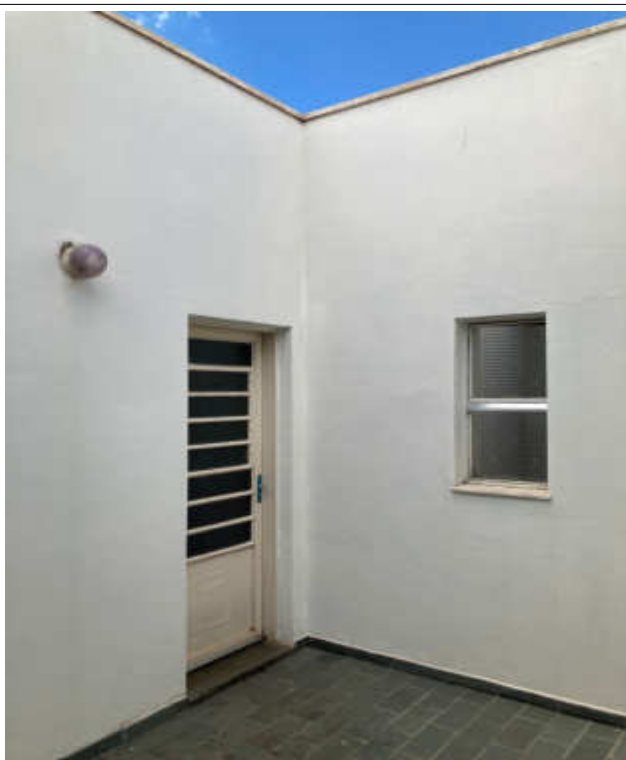
Hall edificação objeto.
