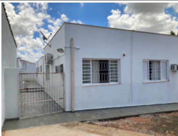
Edificação objeto, portão, iluminação externa, janelas, ar-condicionado, antena e camera.
