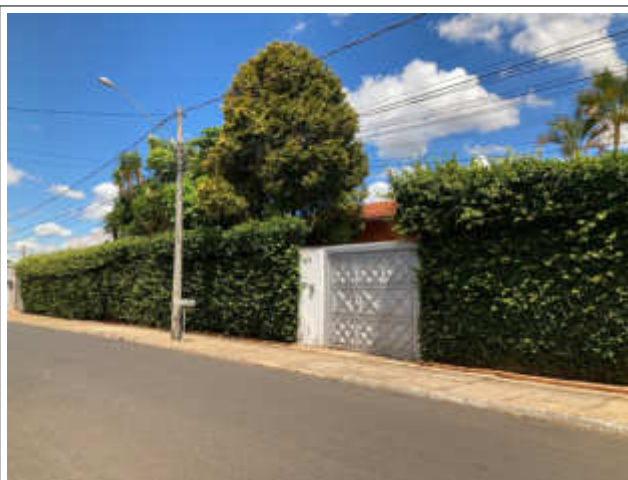
Gradil em alvenaria e cerca viva – lado esquerdo
