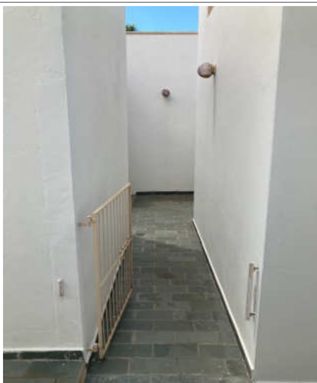
Corredor acesso a edificação objeto.
