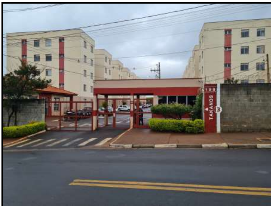
PORTARIA DO CONDOMÍNIO.
