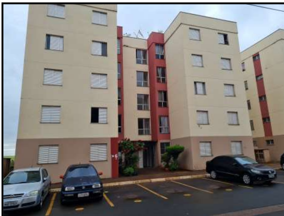
VISTA DA FACHADA DO BLOCO 06
