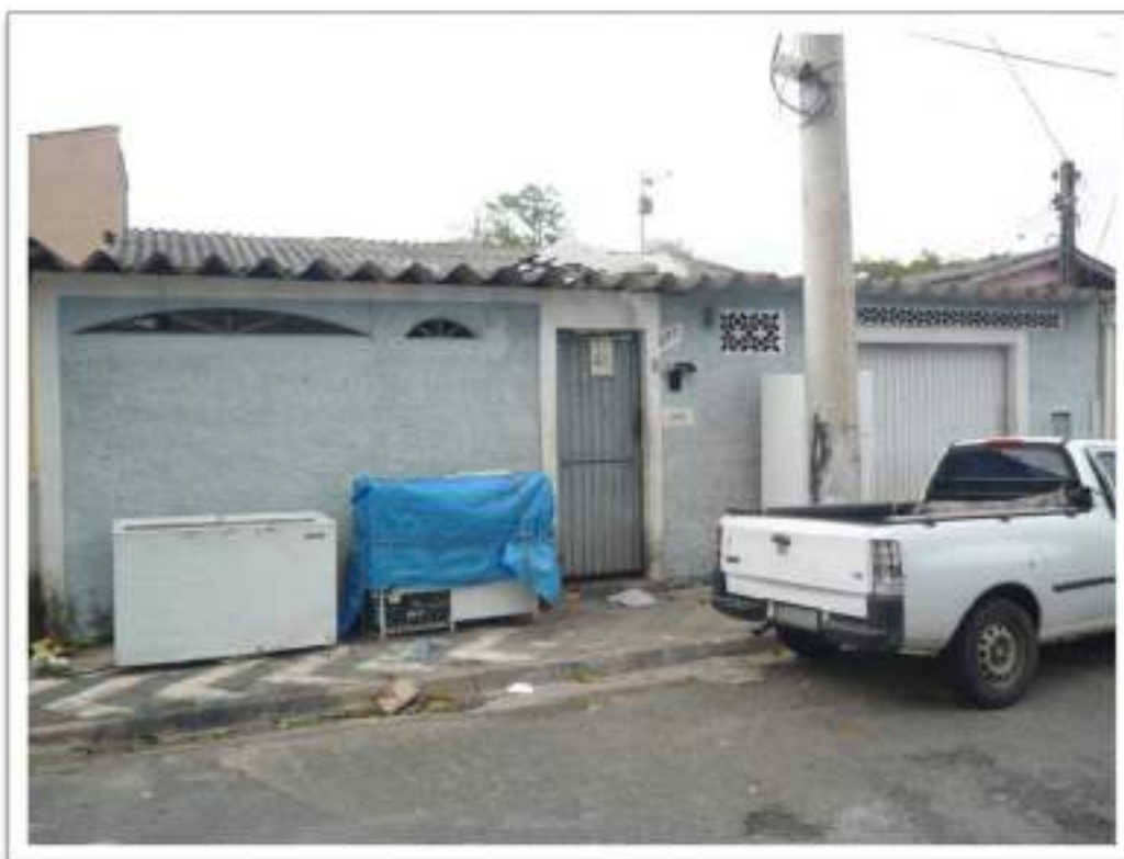
Figura 1 - Vista geral do Imóvel
