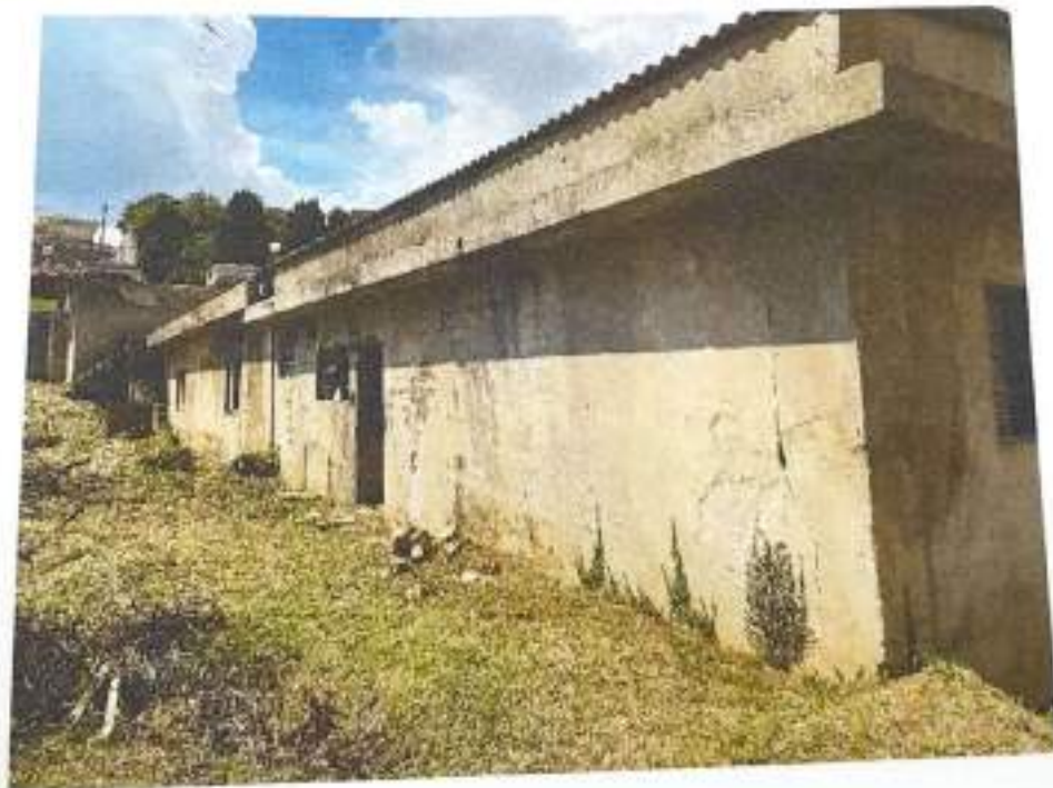
FACHADA E BENFEITORIAS NO LOTE 05 DA QUADRA N
