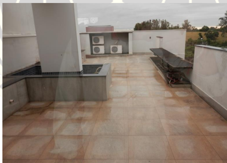
Figura 14: vista do terraço que dá vista à piscina com detalhe ao acabamento fino do reservatório de água em torno do pilar
