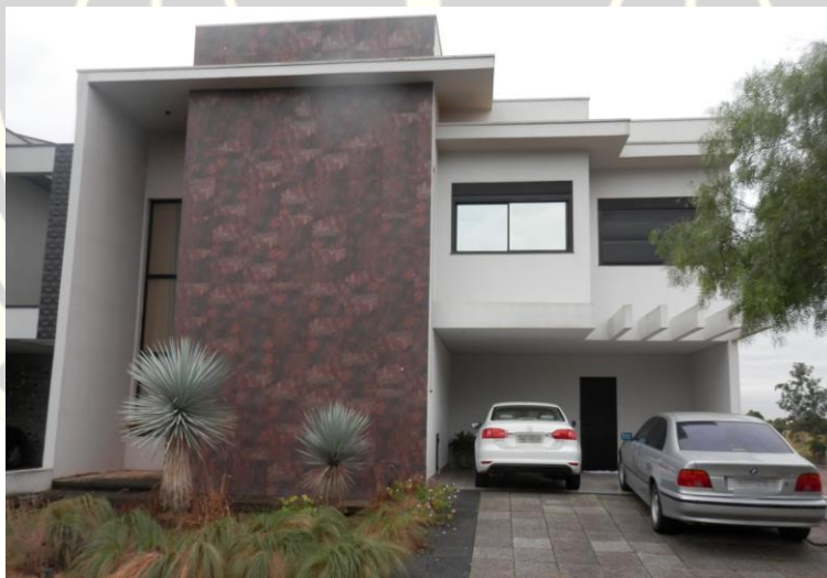
Figura 4: vista geral da fachada
