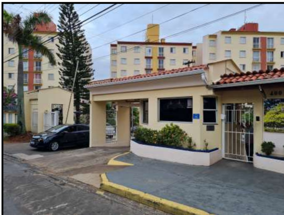
3. VISTA GERAL DA PORTARIA DE ACESSO AO CONDOMÍNIO.
