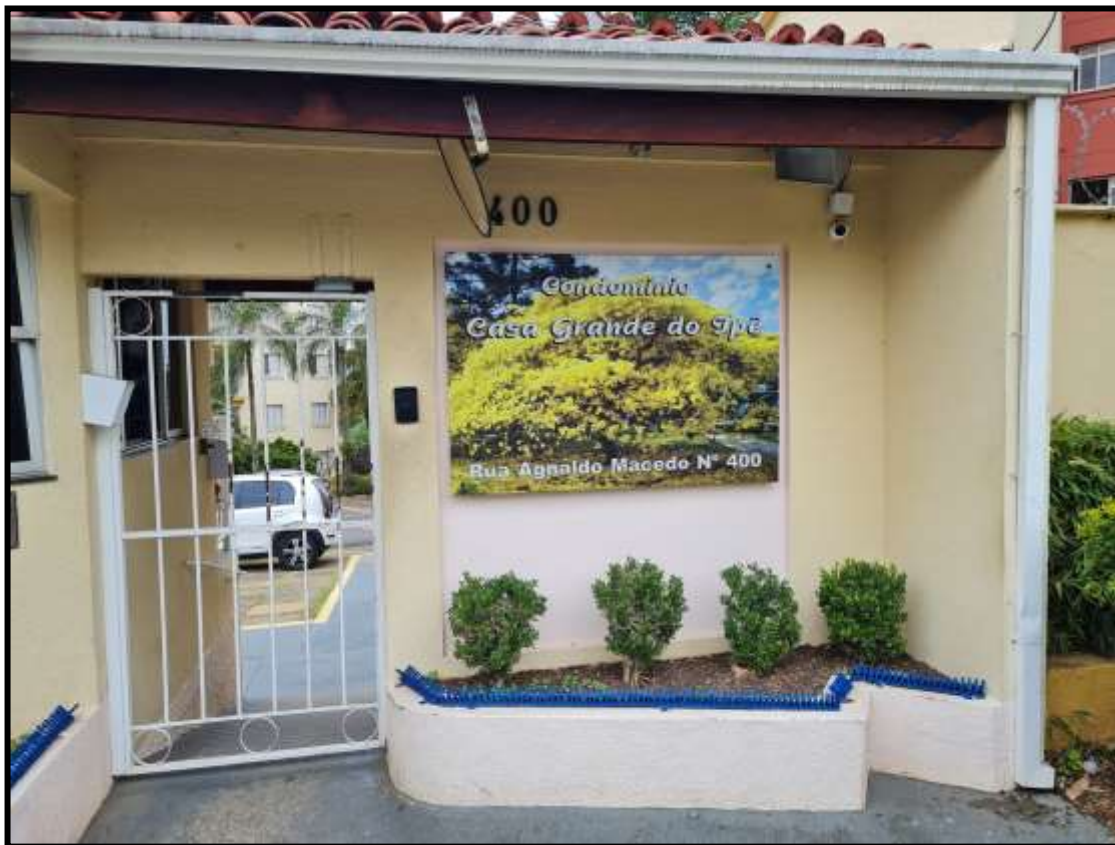
1. PORTARIA DO CONDOMÍNIO.
