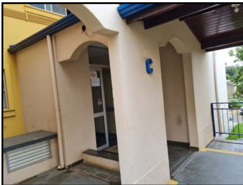
6. ACESSO AO BLOCO C.
