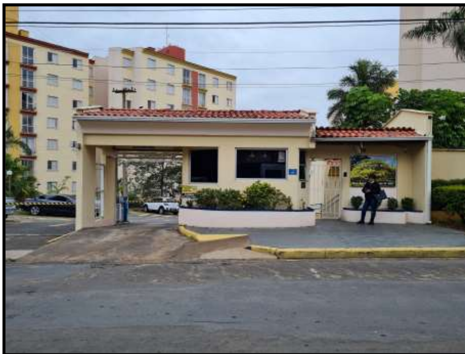
2. VISTA GERAL DA PORTARIA DE ACESSO AO CONDOMÍNIO.
