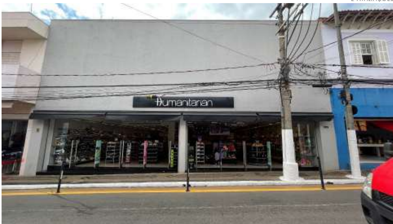
FOTO DE Nº 29. Fachada do imóvel Nº 995.
