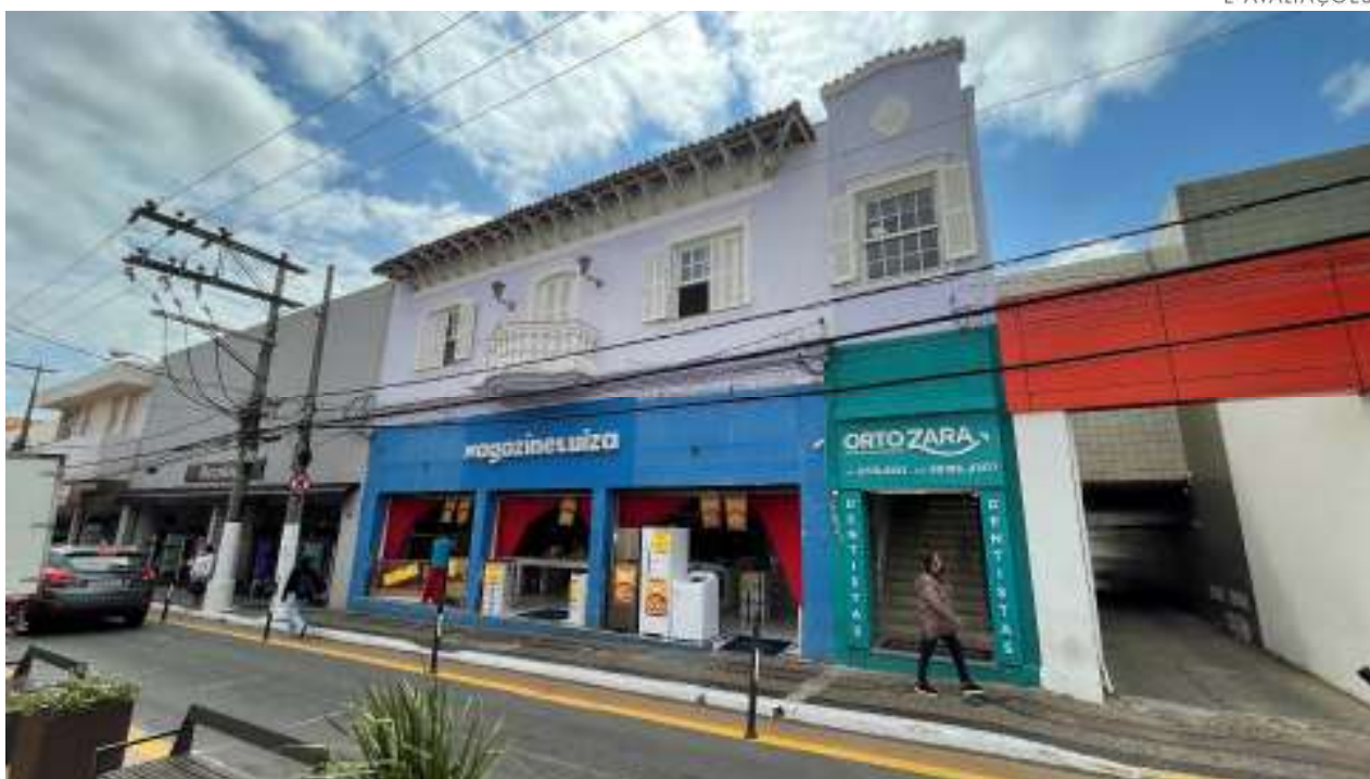
FOTO DE Nº 1. Fachada do imóvel Nº 1015/1021.
