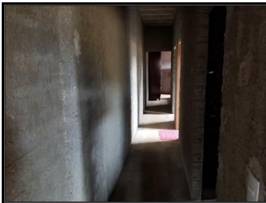
Corredor de distribuição.
