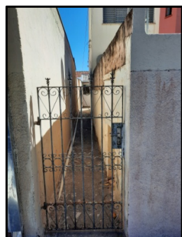
Entrada lateral para edícula
