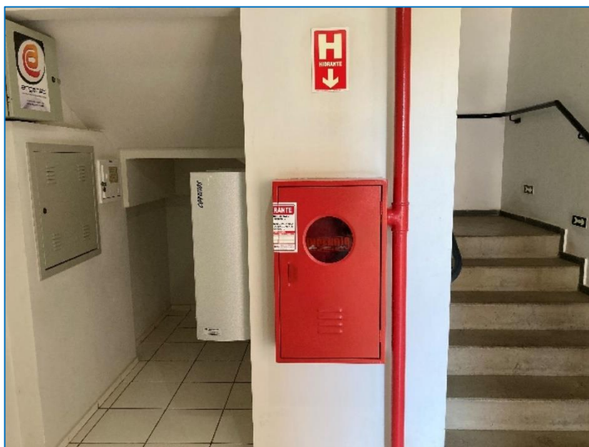
Foto 8 – Vista parcial do piso térreo
