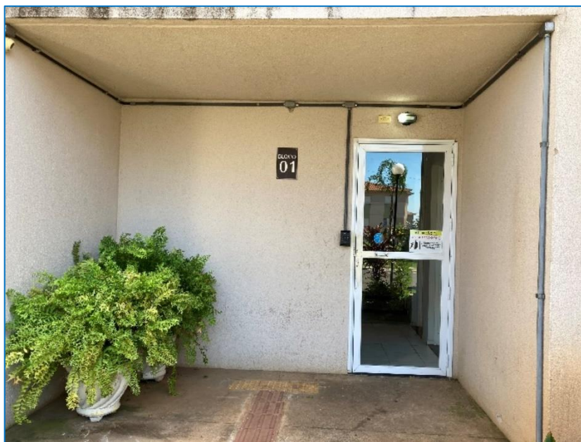
Foto 7 – Entrada para o Bloco 01
