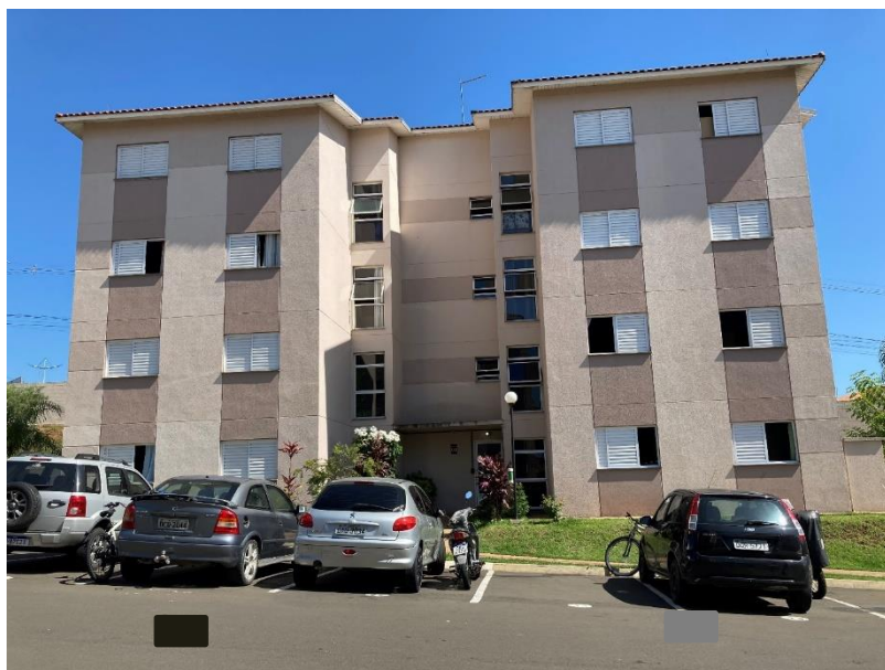
Foto 6 – Fachada do Bloco 1
