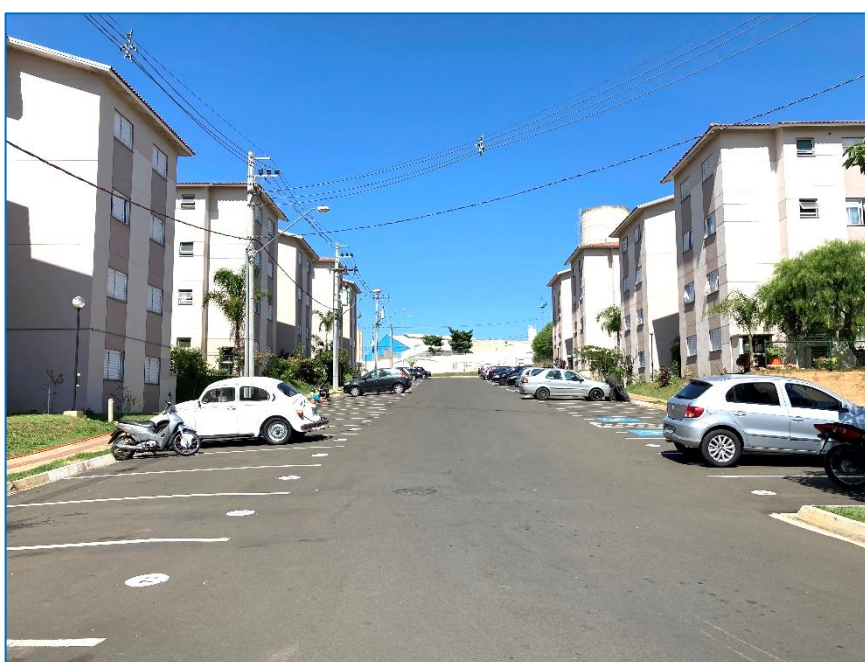
Foto 3 – Vista da via em frente ao prédio do apartamento
