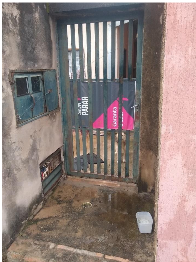
Figura 3 - Vista frontal do imóvel
