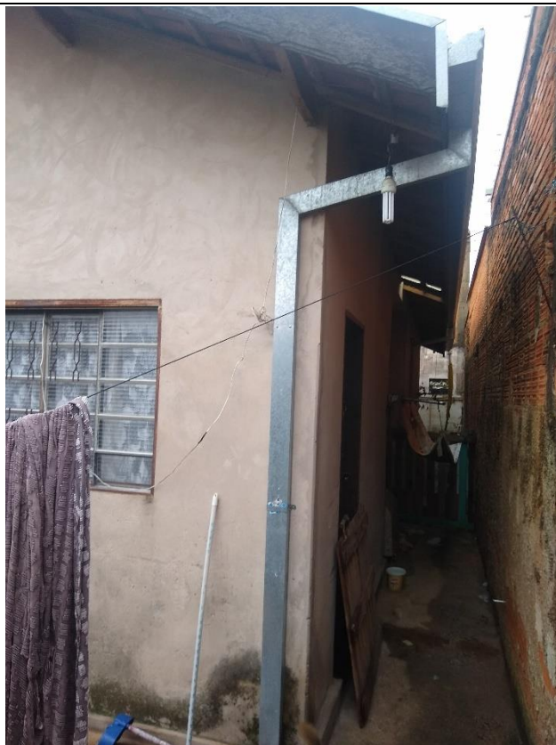
Figura 7 - Vista externa do imóvel
