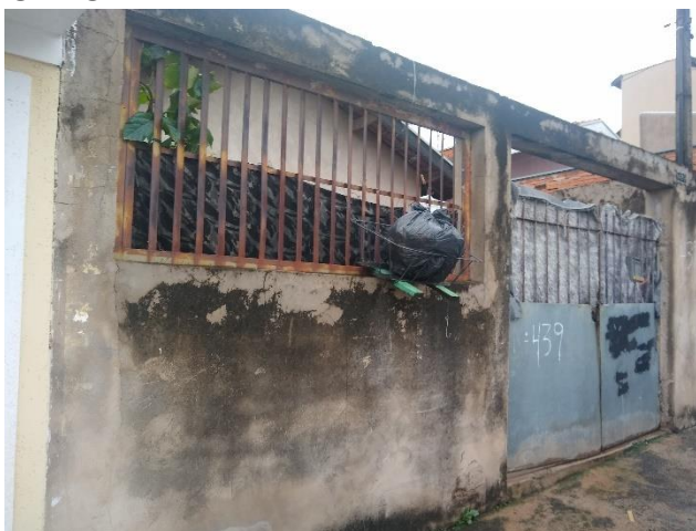
Figura 2 - Vista frontal do imóvel
