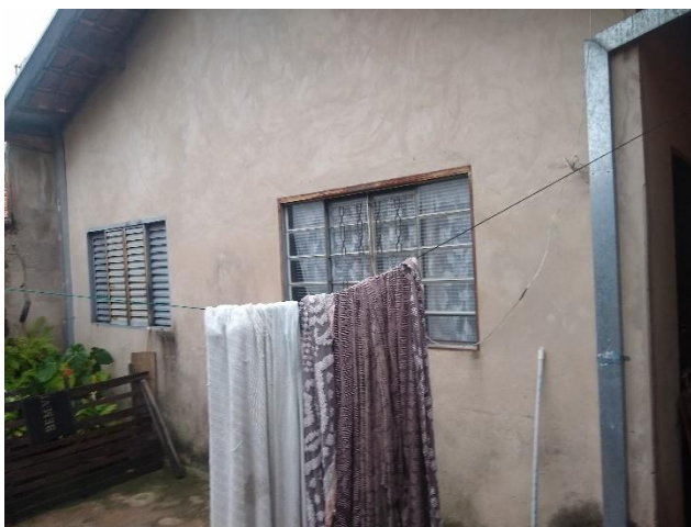
Figura 8 - Vista externa do imóvel
