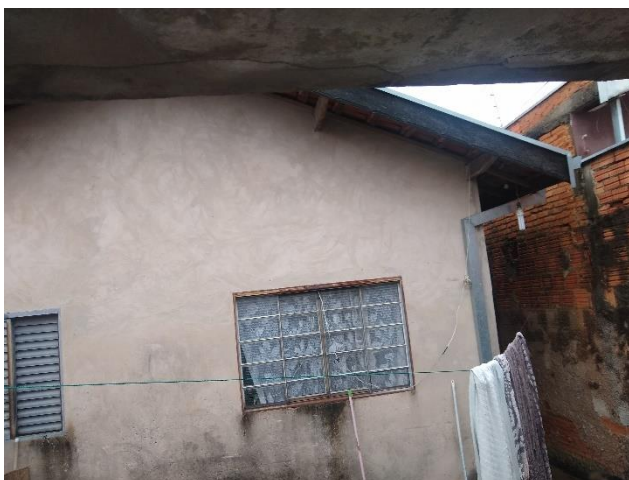
Figura 6 - Vista externa do imóvel
