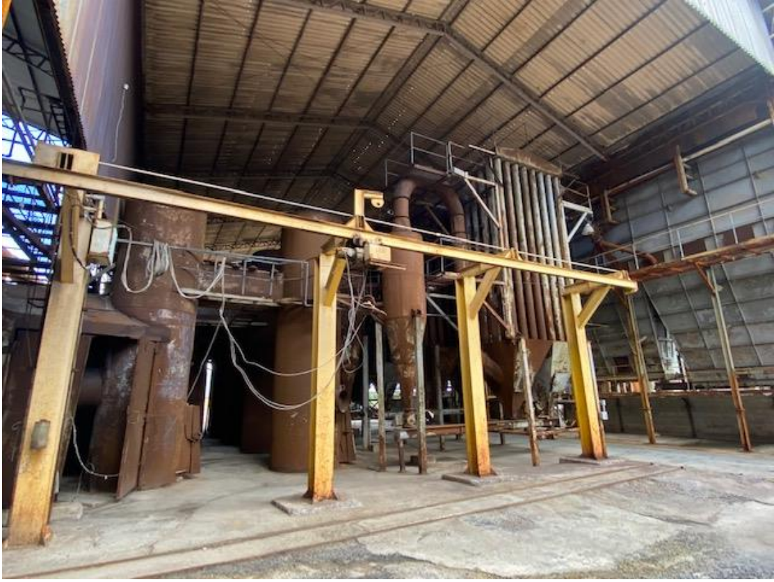
Conjunto Gaseificadores e Filtros
