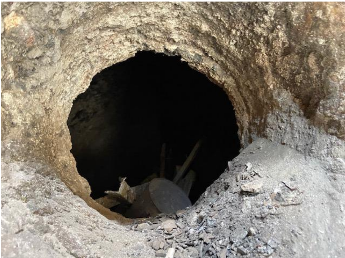
“Boca do 1 forno” – Deteriorado
