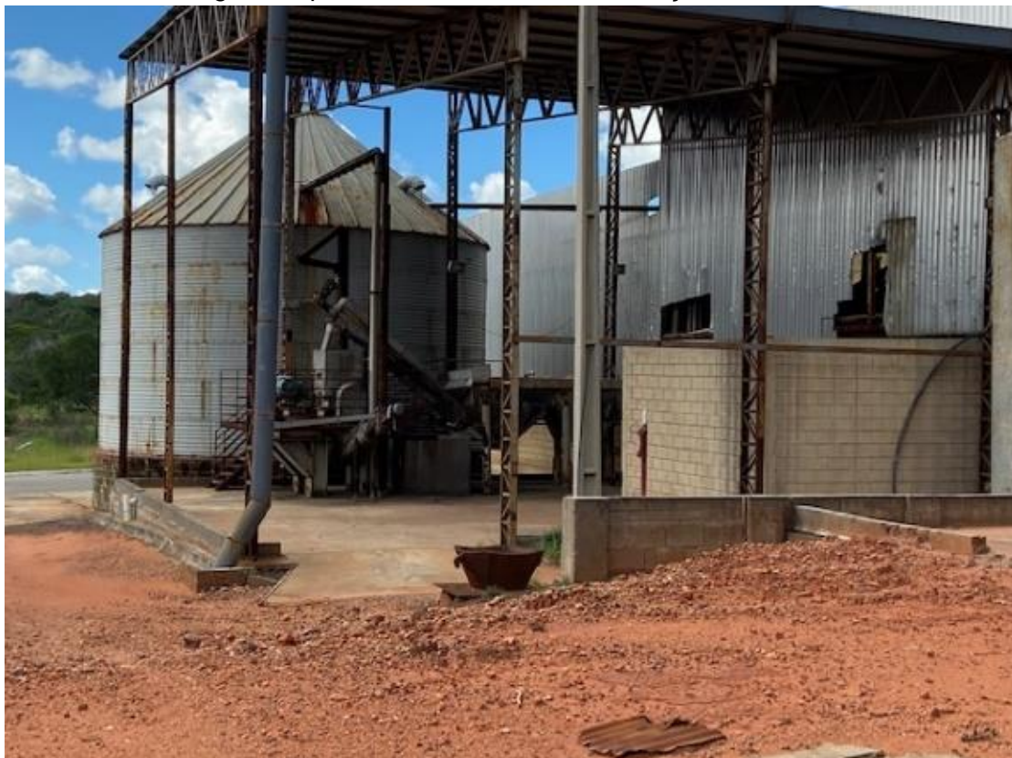
Silo de armazenagem de plásticos – Item de difícil remoção e com corrosão
