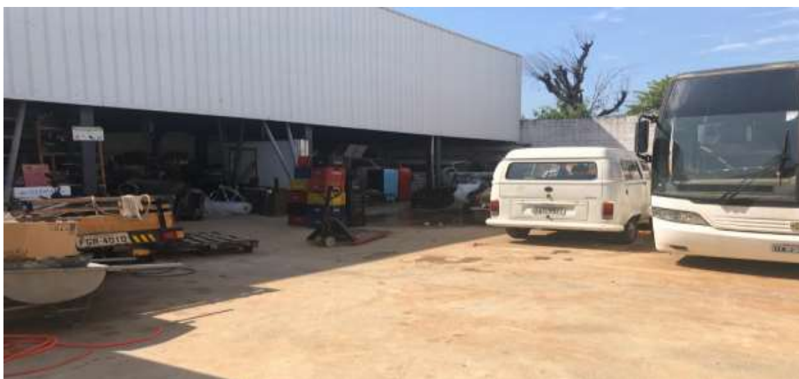
Armazém nos fundos - estacionamento interno descoberto
