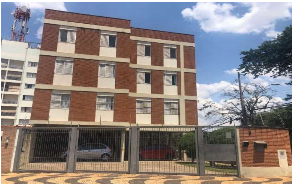
Frente do edifício e entrada de pedestres
