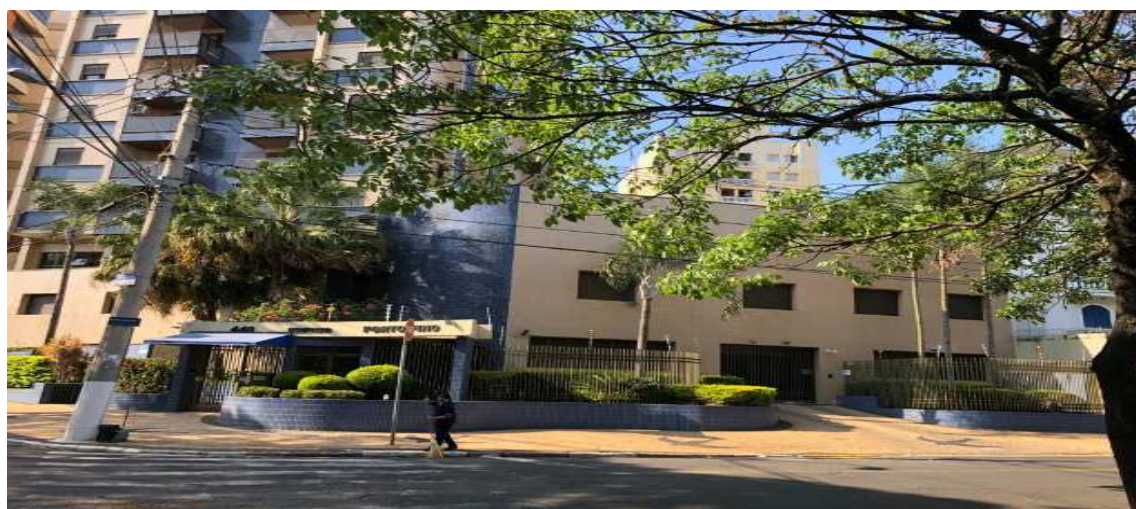
Visão portaria e acesso a garagens
