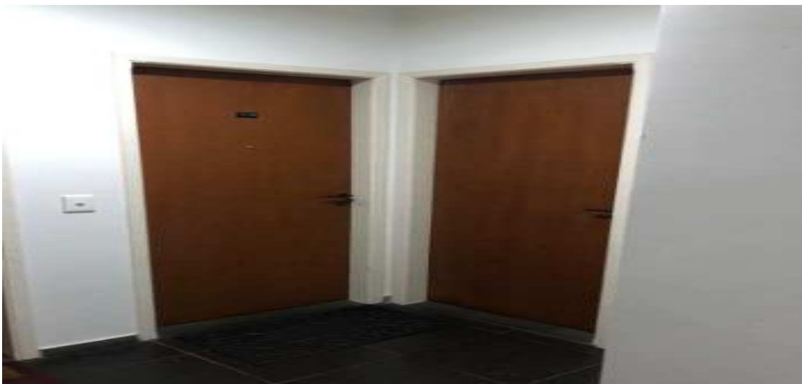
Visão externa dos acessos ao apartamento
