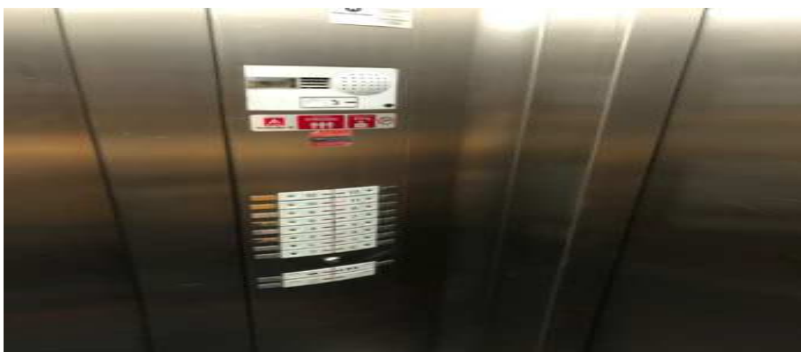
Visão interna do elevador
