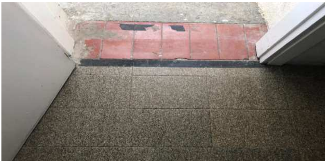
Detalhe dos pisos
