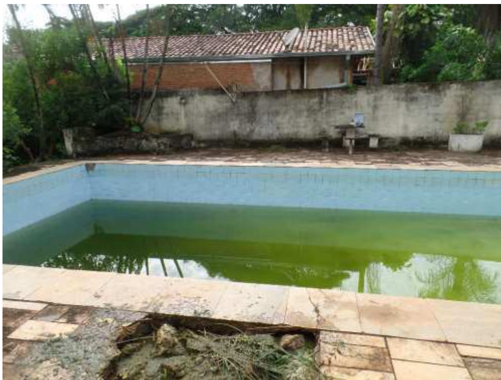
FOTO N.º 24- Detalhe da piscina com área construída de 112,00 m² .
