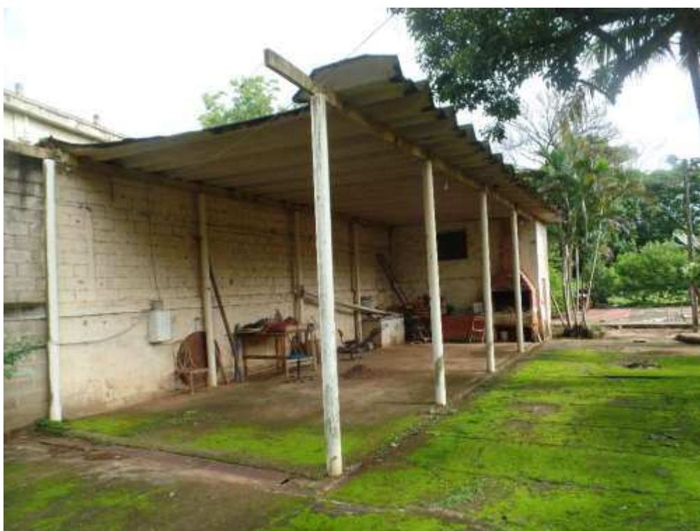
FOTO N.º 19- Aspecto do galpão externo com área construída de 80,00 m².
