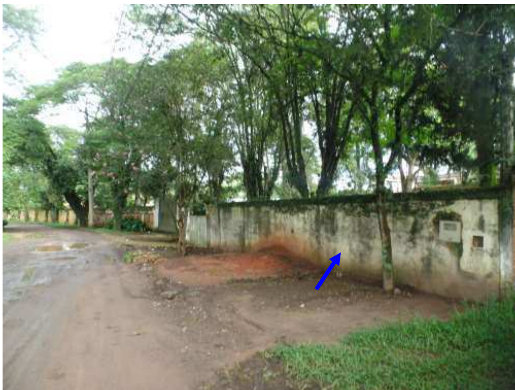
FOTO N.º 02- Vista externa do imóvel avaliando com muro frontal.
