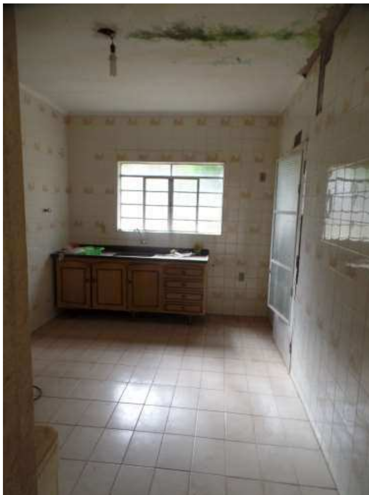
FOTO N.º 11- Aspecto da cozinha.
