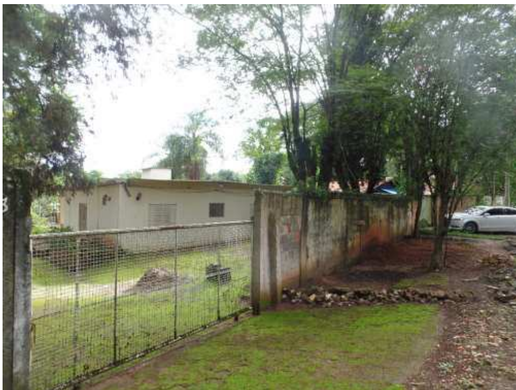
FOTO N.º 04- Vista externa da fachada do imóvel avaliando.
