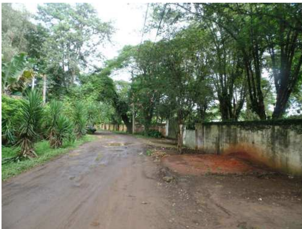
FOTO N.º 03- Tomada externa da Rua Abílio Vilela Junqueira com rua em terra batida e cascalho.
