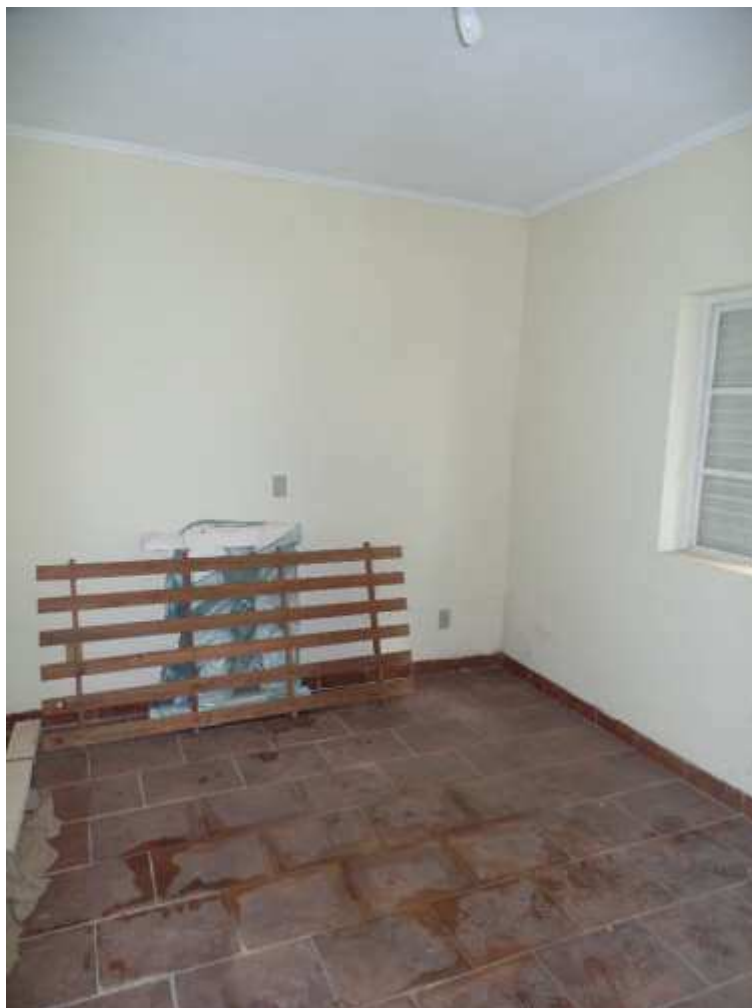
FOTO N.º 17- Vista do dormitório n.º 03.
