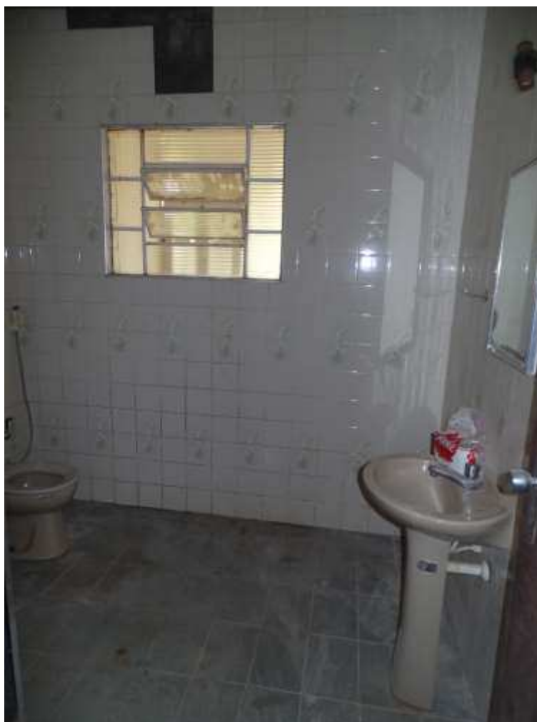
FOTO N.º 13- Vista do banheiro social.
