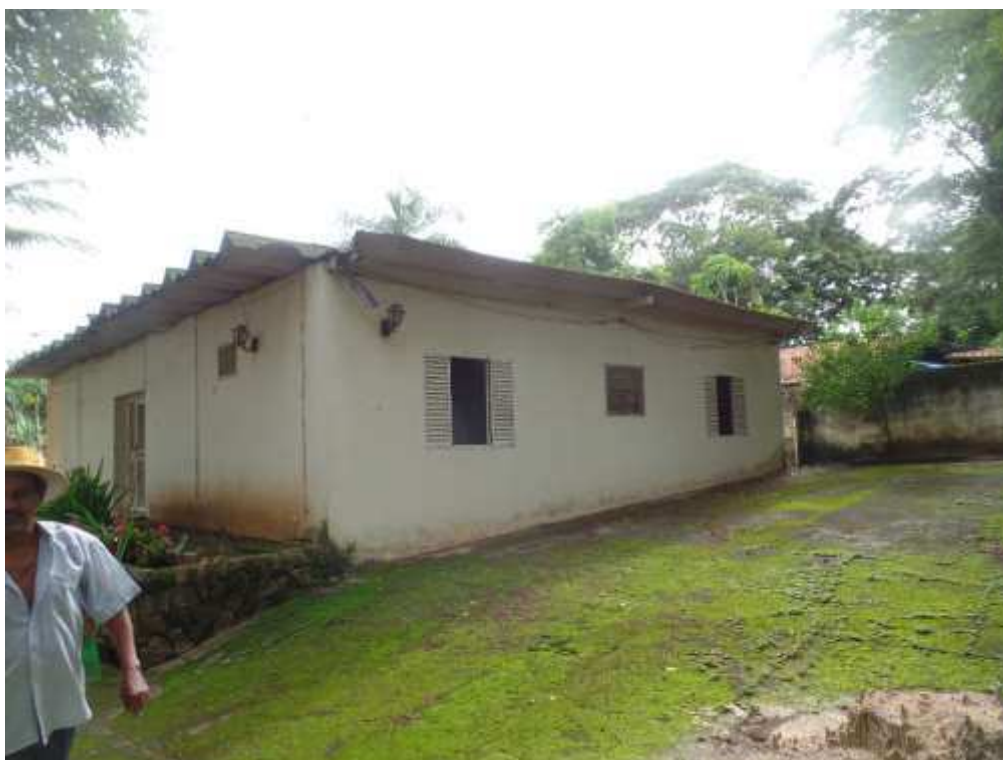
FOTO N.º 09- Aspecto frontal da casa sede principal.
