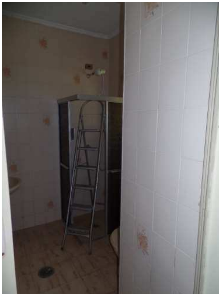
FOTO N.º 16- Detalhe do banheiro do dormitório n.º 02.
