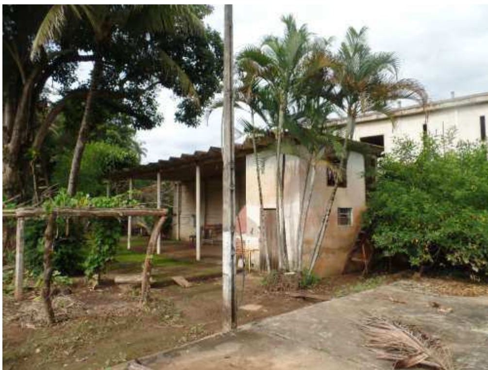
FOTO N.º 23- Aspecto do galpão externo com área construída de 80,00 m² .
