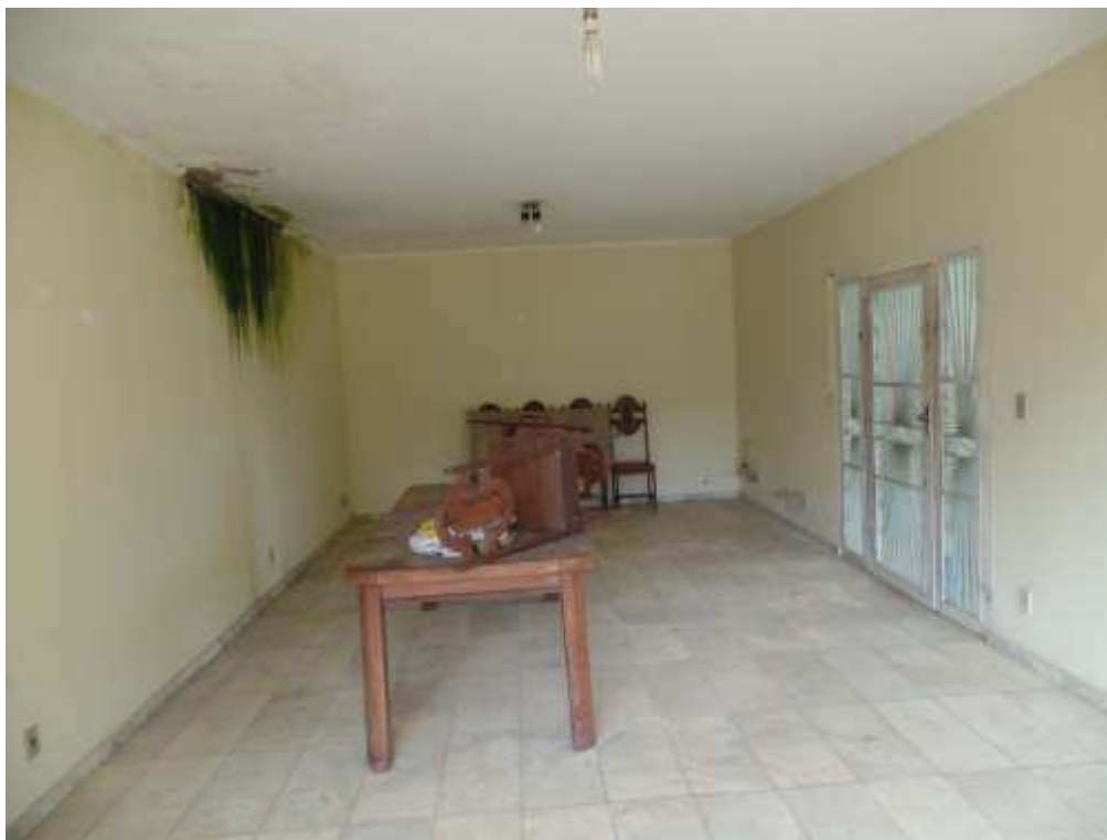
FOTO N.º 10- Tomada interna da sala.
