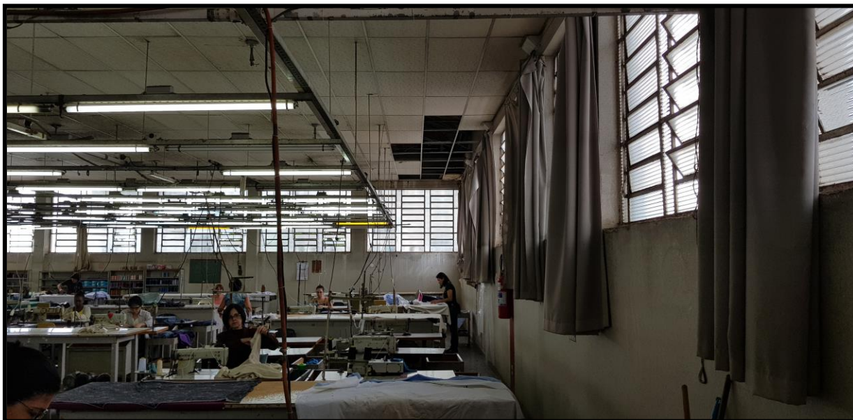
36. Vista interna do pavimento superior.
