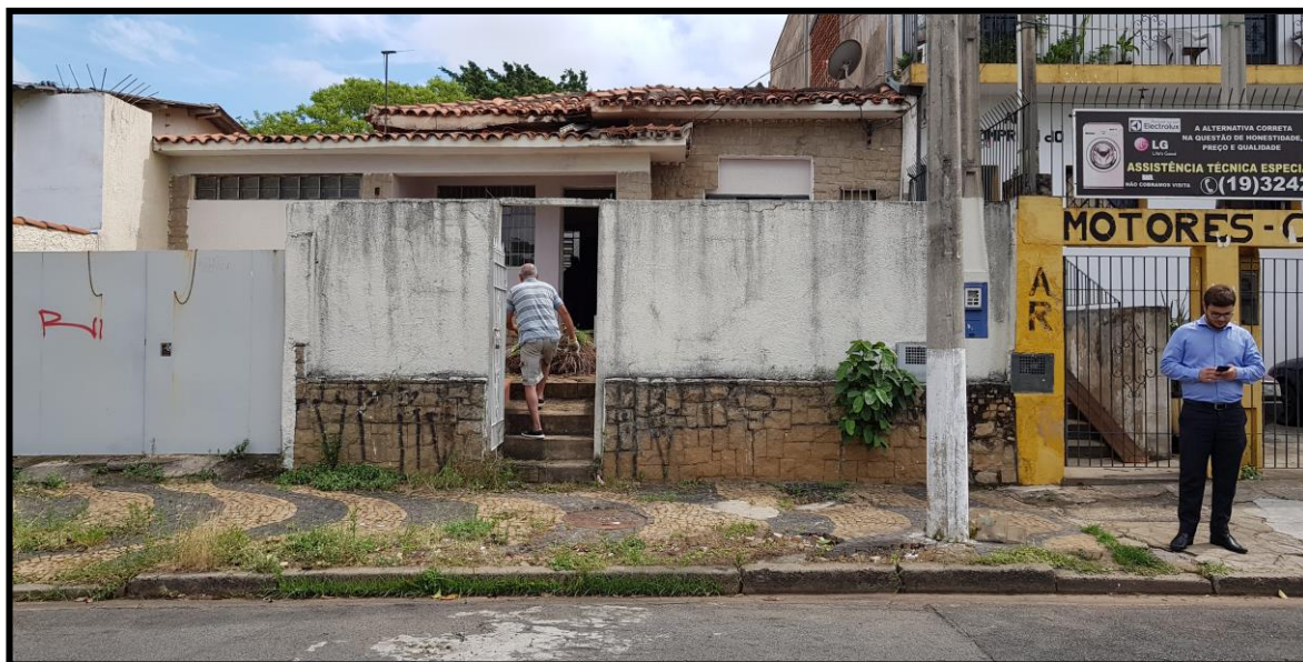
38. Vista da fachada do imóvel, feita da Rua Major Luciano Teixeira.
