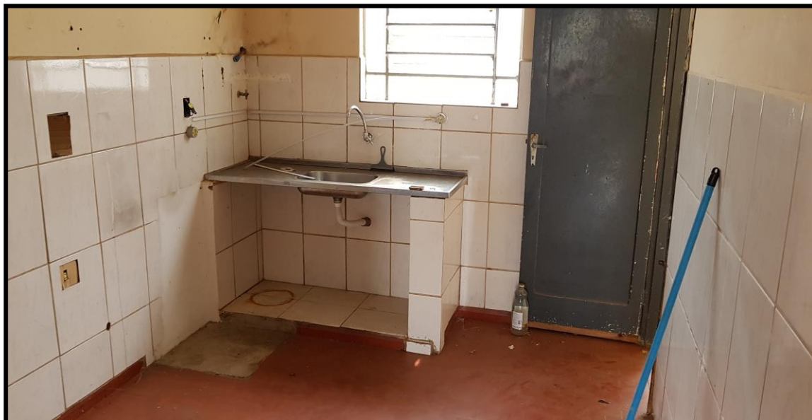
41. Vista interna da cozinha.
