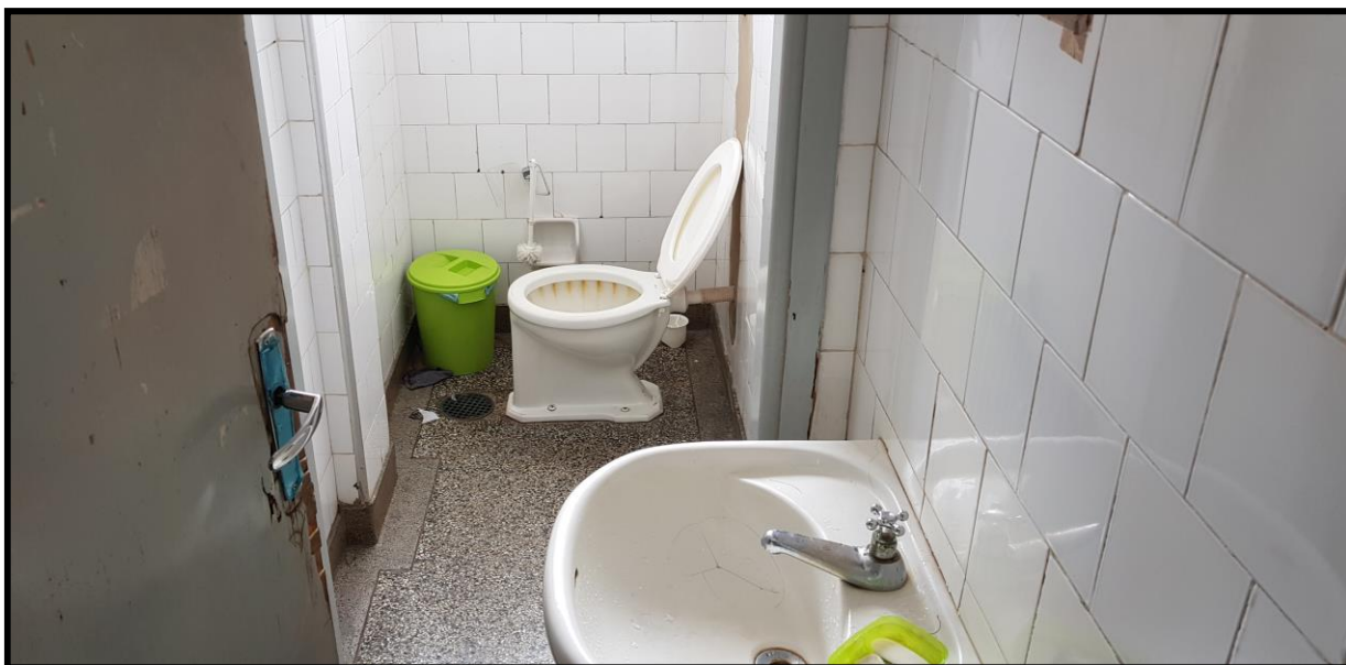
37. Vista interna de um dos banheiros do pavimento superior.
