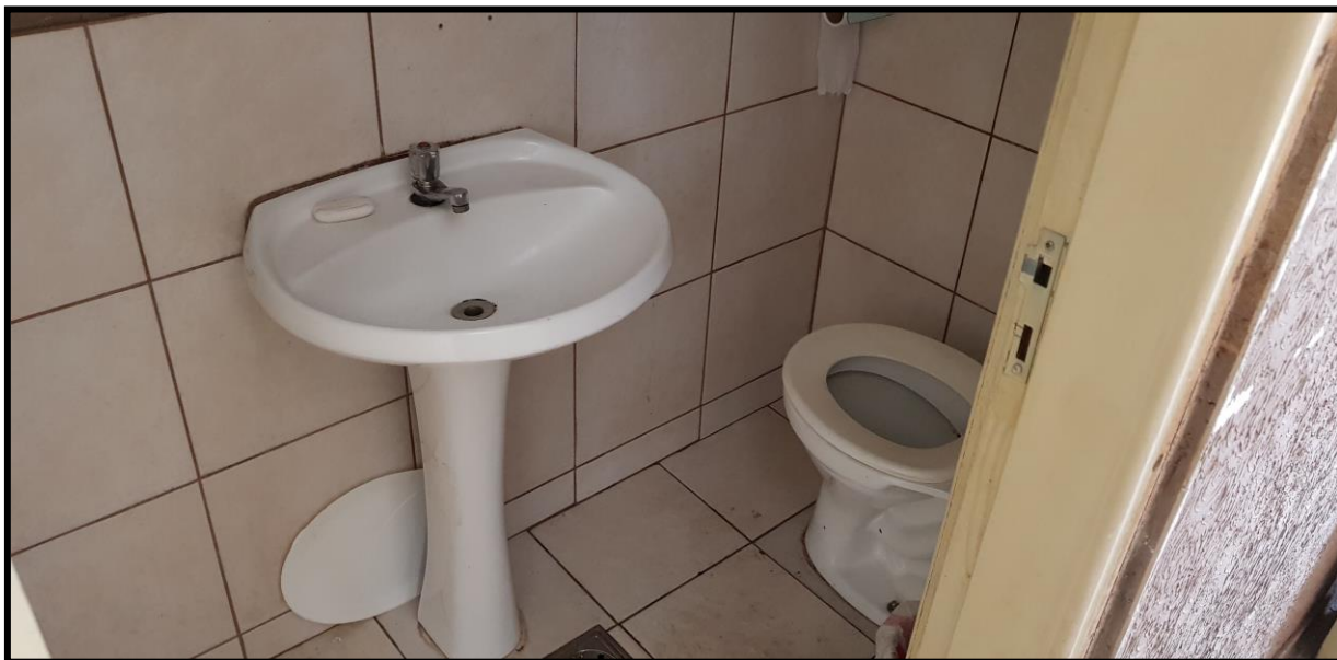
28. Pavimento térreo. Vista de um dos banheiros.
