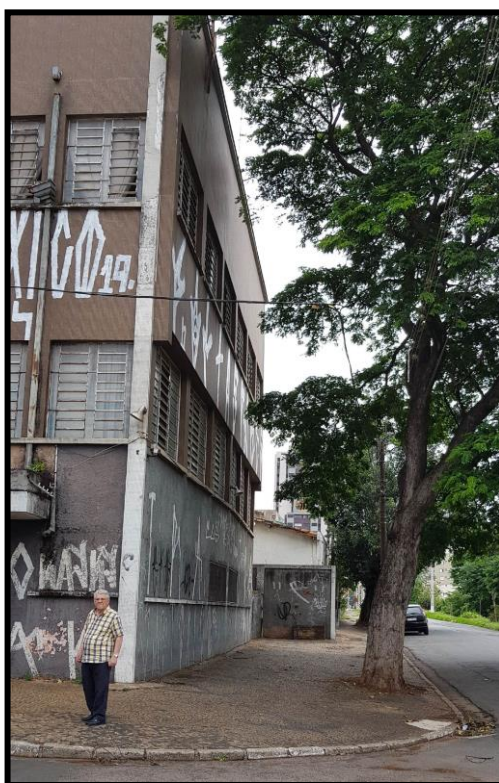
24. Fachada lateral e dos fundos do imóvel, visto da confluência das Ruas do Açúcar e Major Luciano Teixeira.
