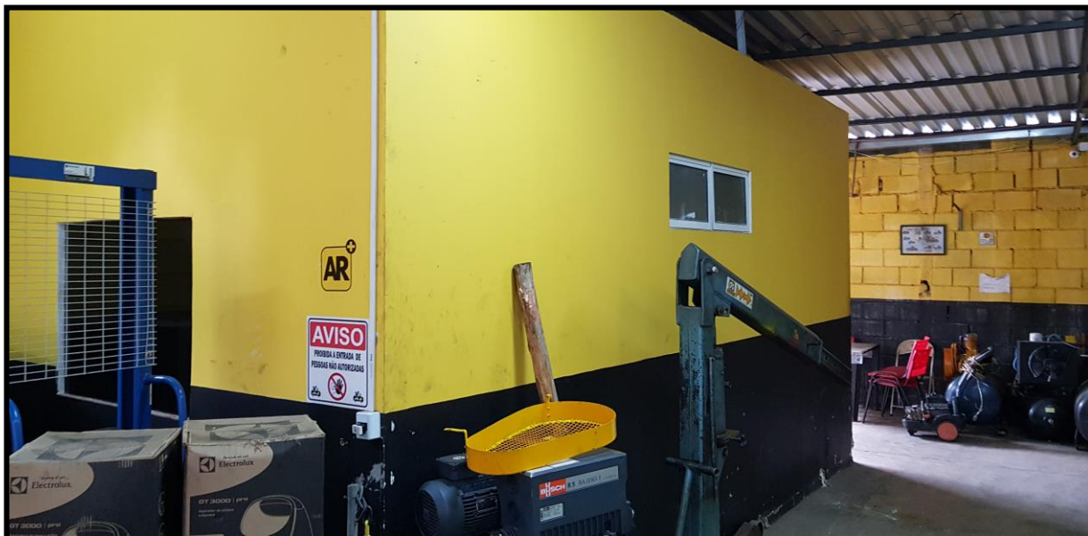
13. Vista interna do galpão com destaque para a sala de escritório.
