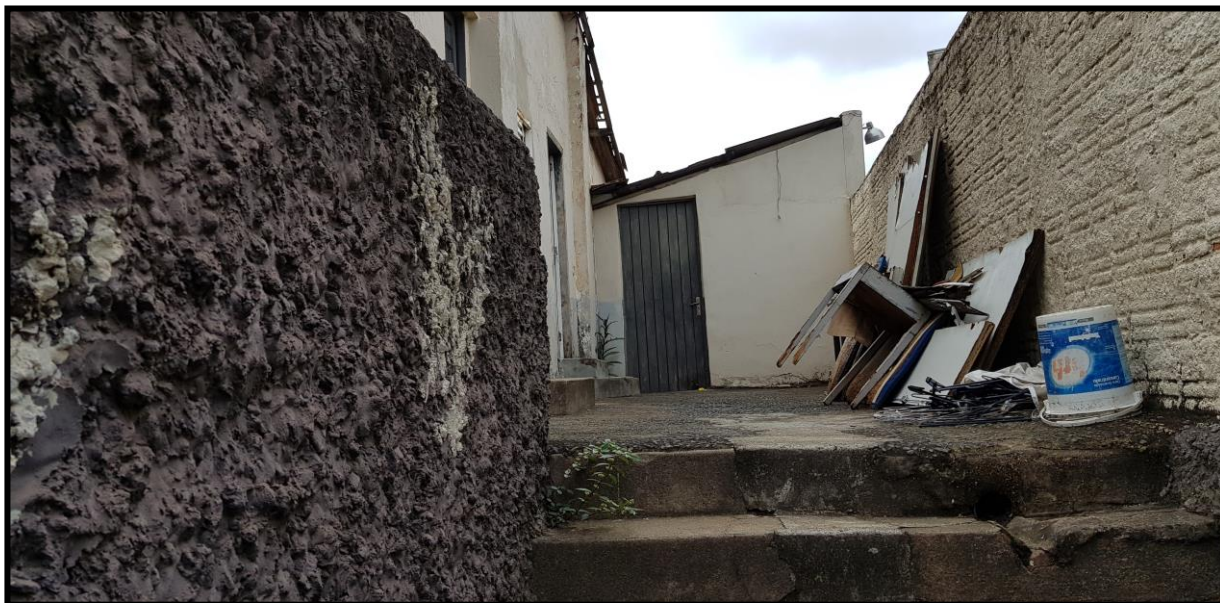
21. Vista do corredor lateral da edificação.
