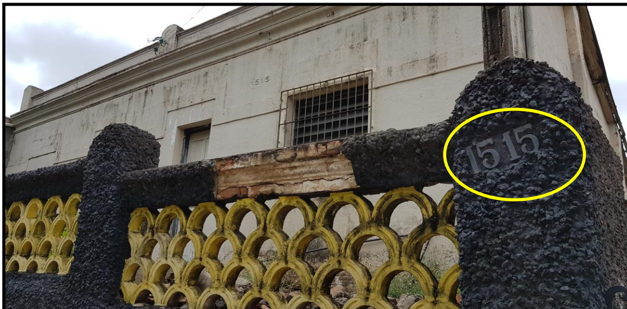
19. Tomada da Avenida Governador Pedro de Toledo, mostrando a fachada do imóvel.
