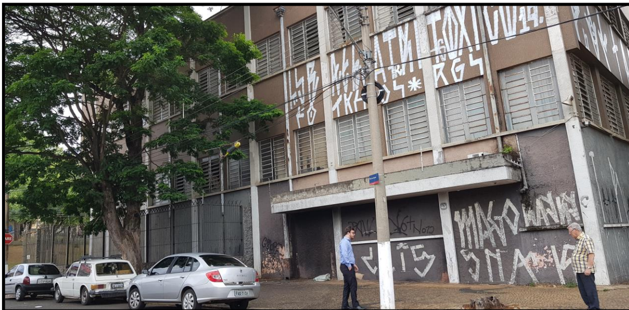
23. Vista da fachada lateral do prédio feito da Rua do Açúcar.
