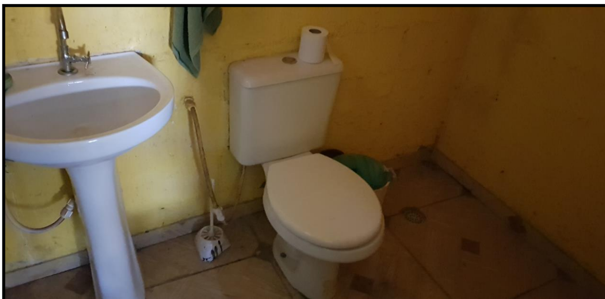
18. Vista interna do banheiro.
