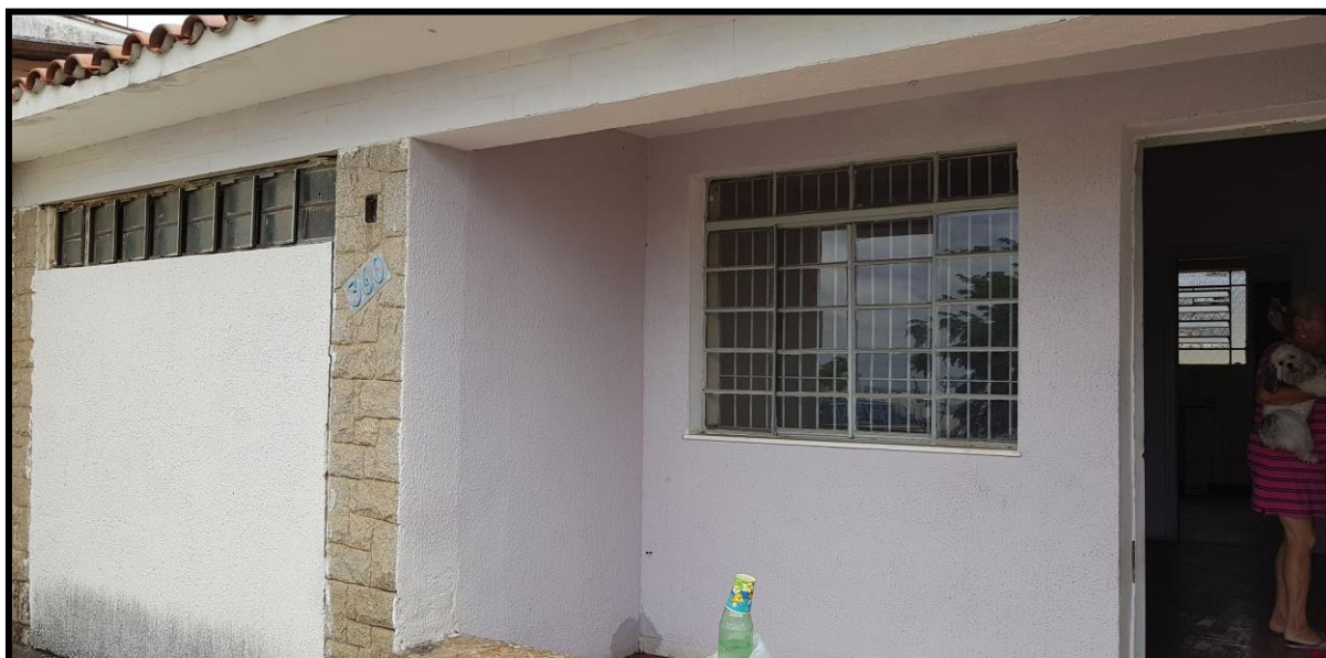
39. Vista da fachada da edificação, com destaque para a varanda.
