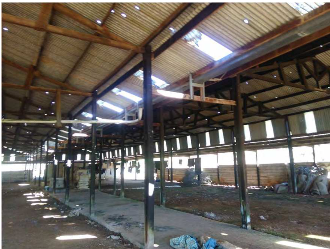
Foto 18: Interior do Galpão
