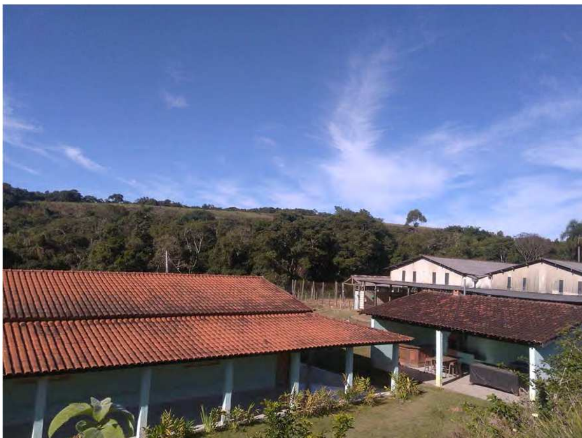
Foto 14: vista geral das edificações (casa sede e galpão)
