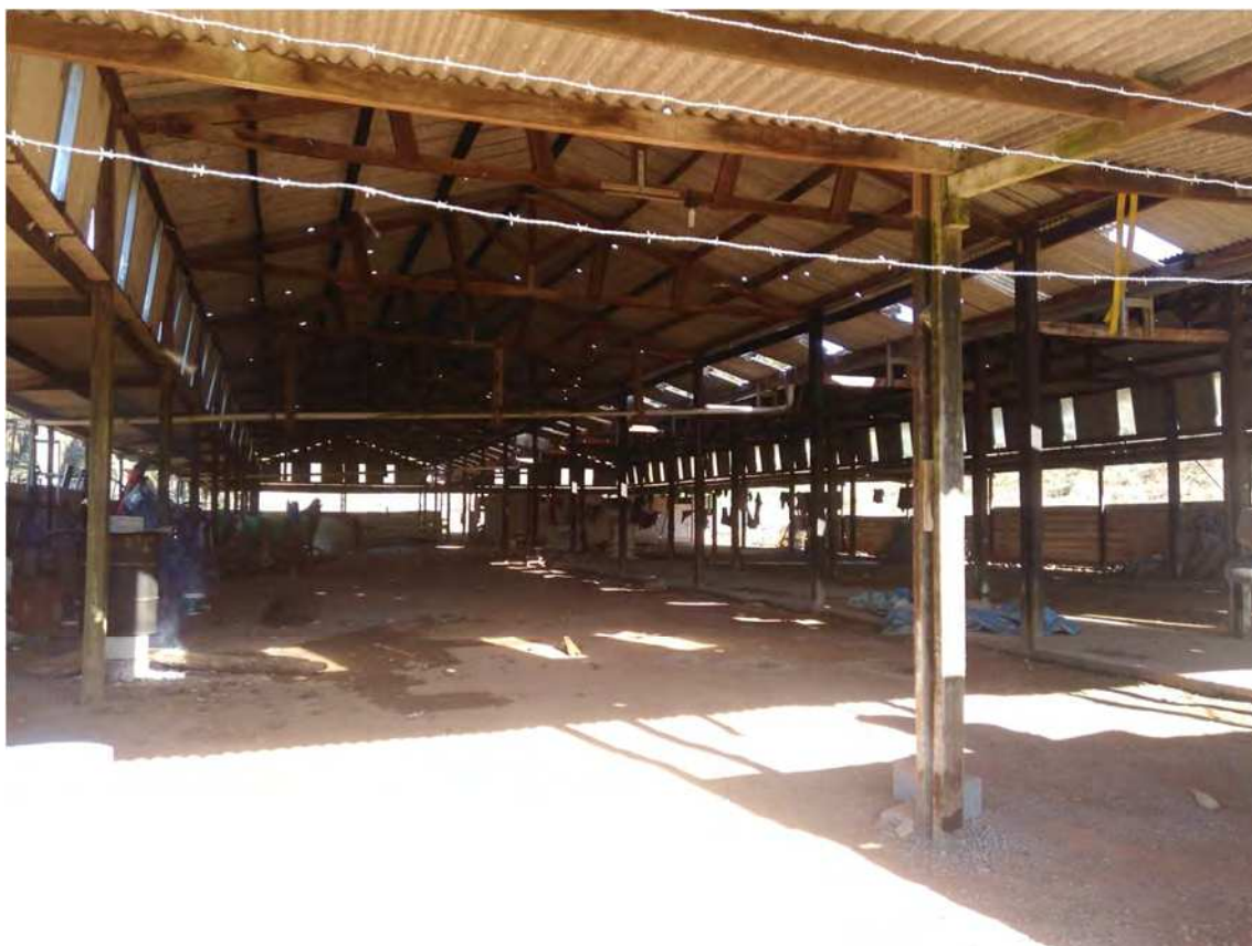
Foto 16: Interior do Galpão
