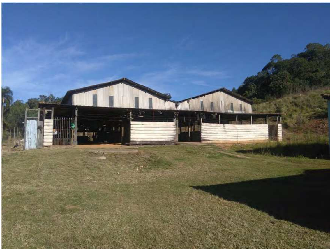
Foto 15: Galpão com estrutura de madeira
