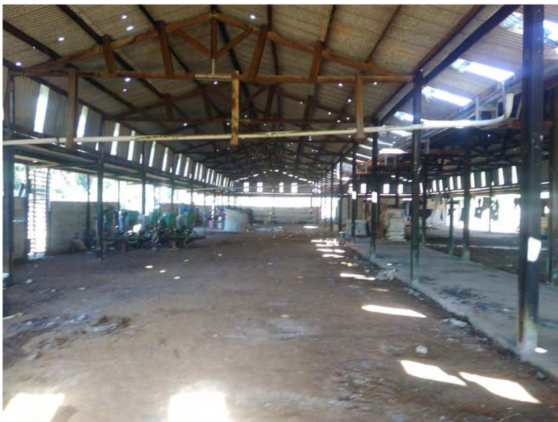
Foto 17: Interior do Galpão
