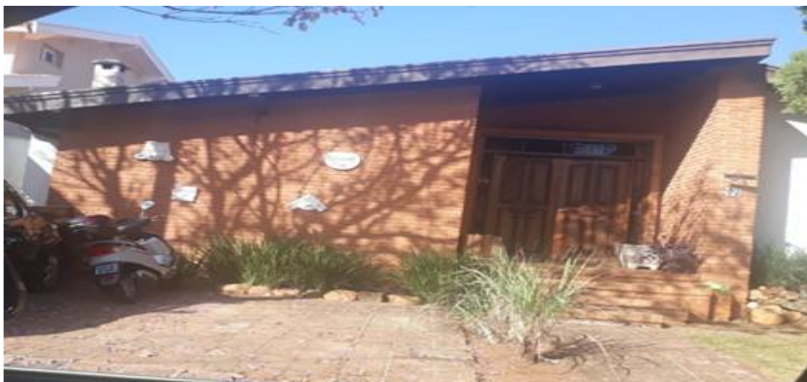
Visão frente do imóvel
