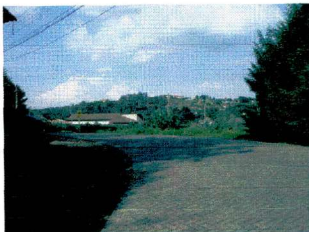
FOTO N.º 17- Vista lateral da fachada do lote, vendo-se a Alameda Tabajara.
