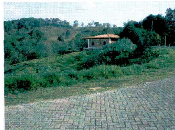
FOTO N.º 25- Vista lateral da fachada do imóvel.
