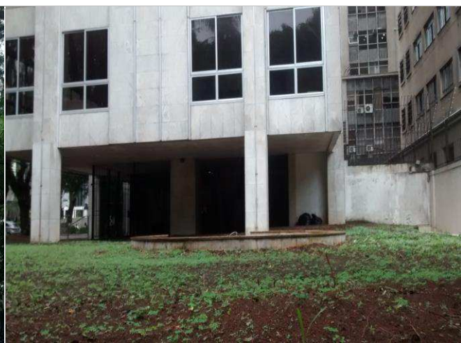
FACHADA VOLTADA PARA RUA PEIXOTO GOMIDE
