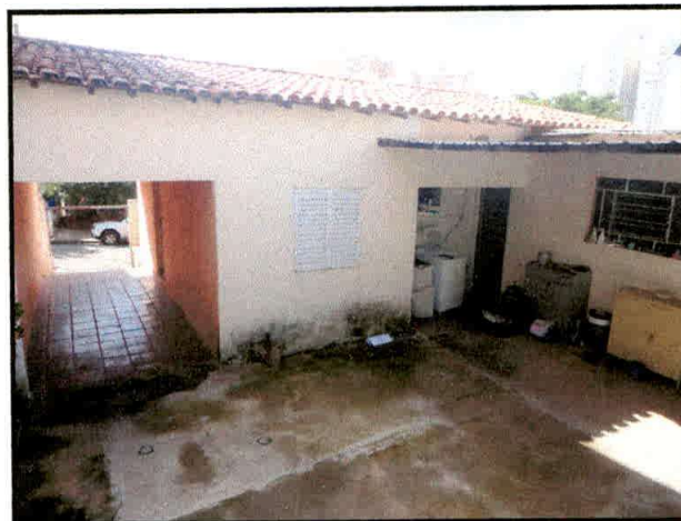
VISTA DAS EDIFICAÇÕES 1 E 2.
