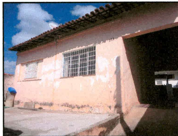
EDIFICAÇÃO 1 – FRENTE DO TERRENO
