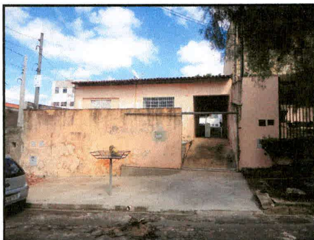
EDIFICAÇÃO 1 – FRENTE DO TERRENO
