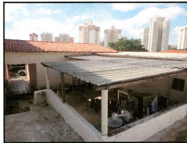
VISTA DA EDIFICAÇÃO 2 NO SENTIDO DA EDIFICAÇÃO 1 (FRENTE DO TERRENO)
