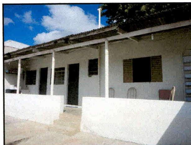
EDÍCULA NOS FUNDOS DO TERRENO (EDIFICAÇÃO 3)
