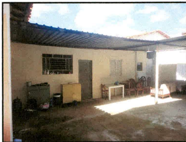
EDIFICAÇÃO 2 – EDÍCULA SITUADA NO MEIO DO TERRENO E AO LADO DA EDIFICAÇÃO 1.
