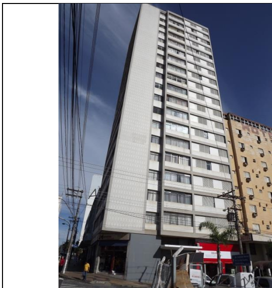
Figura 1- Fachada frontal do imóvel
