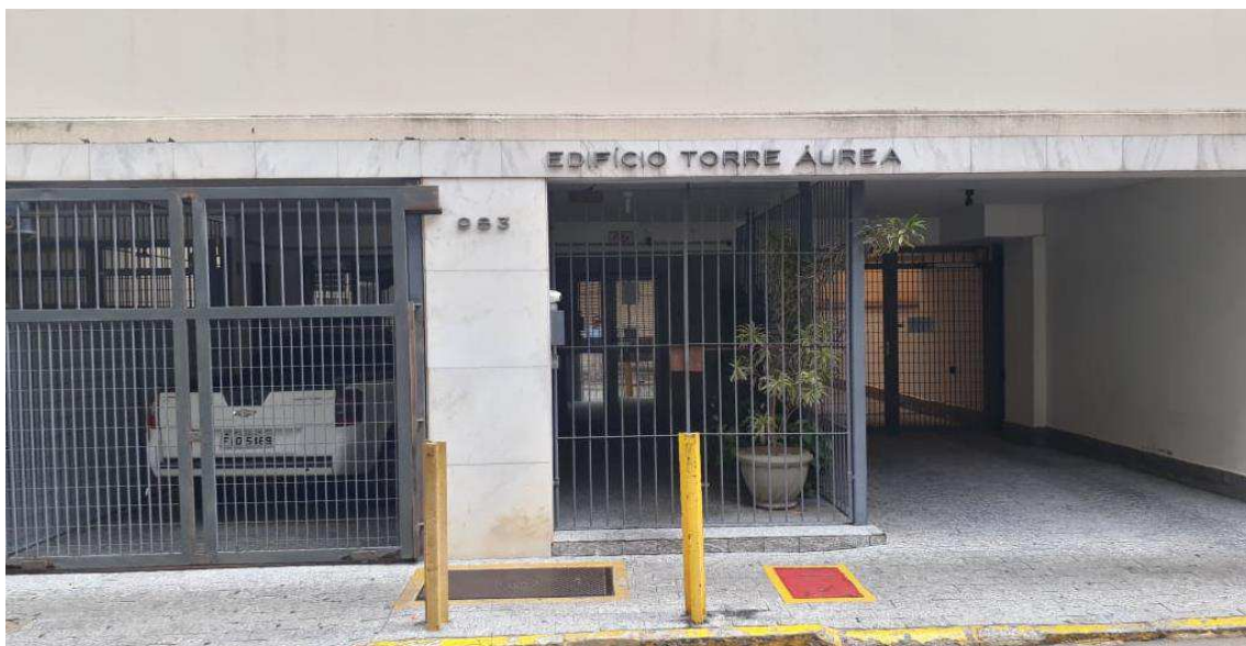
Entrada do prédio
